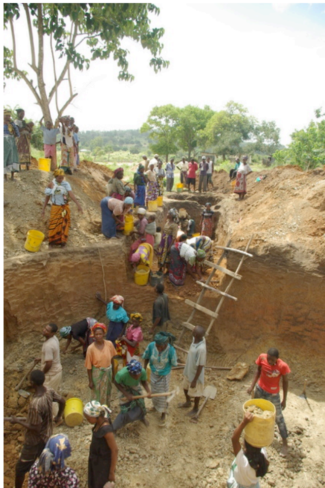
(Ouders van de Vitsangalaweni graven de fundering voor de watertank)
